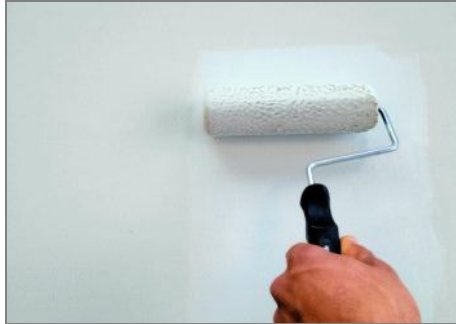
Paso 1 - Para comenzar aplicar Primer Naturale.
